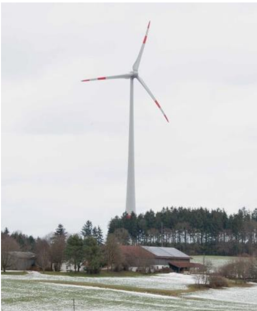
Bürgerwindanlage 2016 Hamberg im Lk Ebersberg E-82/2,3 MW 3 – 4 Mio kWh/a für 8,4 ct/kWh
