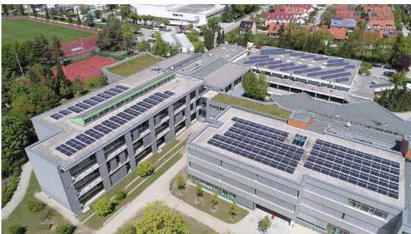
Schulzentrum Gilching Energiegenossenschaft Fünfseenland Dachanlage mit 90 kW. ca. 90.000 kWh/a
