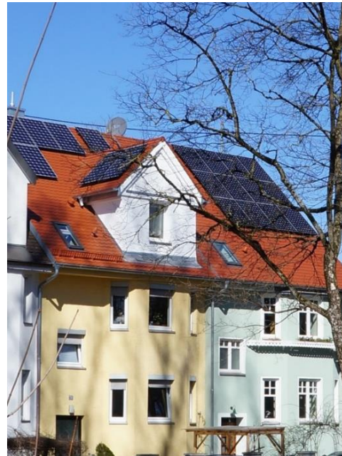
PV-Dachanlage, 10 kW (2 kW auf der rückwärtigen Westseite), liefert bilanziell weit über 100 % des in den zwei Häusern verbrauchten Stroms
